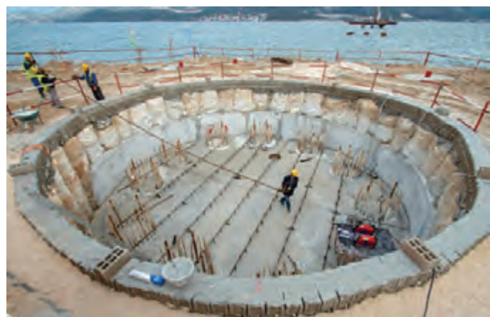
Izvedba temelja stupa S13, uz more, na Pelješcu: vide se vrhovi bušenih pilota nad kojima je izvedena temeljna ploča
