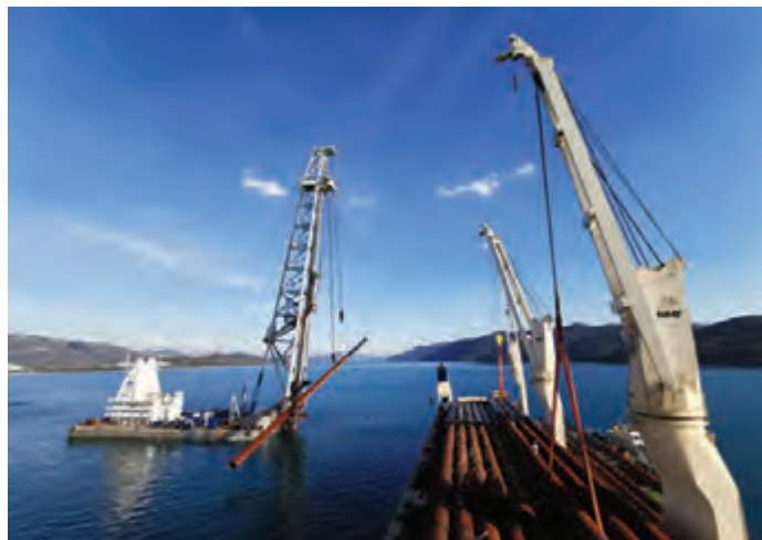
Zabijanje čeličnih pilota Pelješkog mosta: brod s čekićem i tornjem za zabijanje prihvaća pilot dizalicom i zaokreće ga u položaj za zabijanje.
