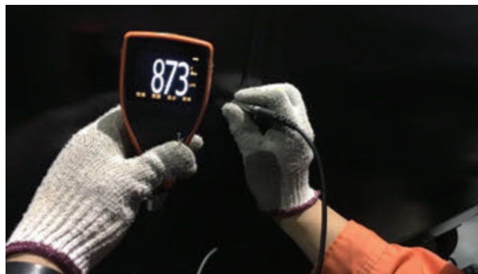
Ispitivanje debljine antikorozivne zaštite pilota Pelješkog mosta, zadana debljina je 850 μm
