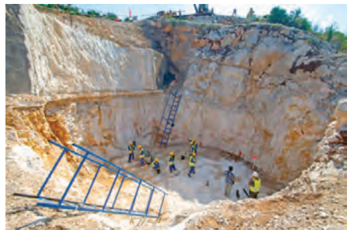
Temeljna jama jedinog stupa na koji je izveden na kopnu, prvog sa strane Komarne – S2
