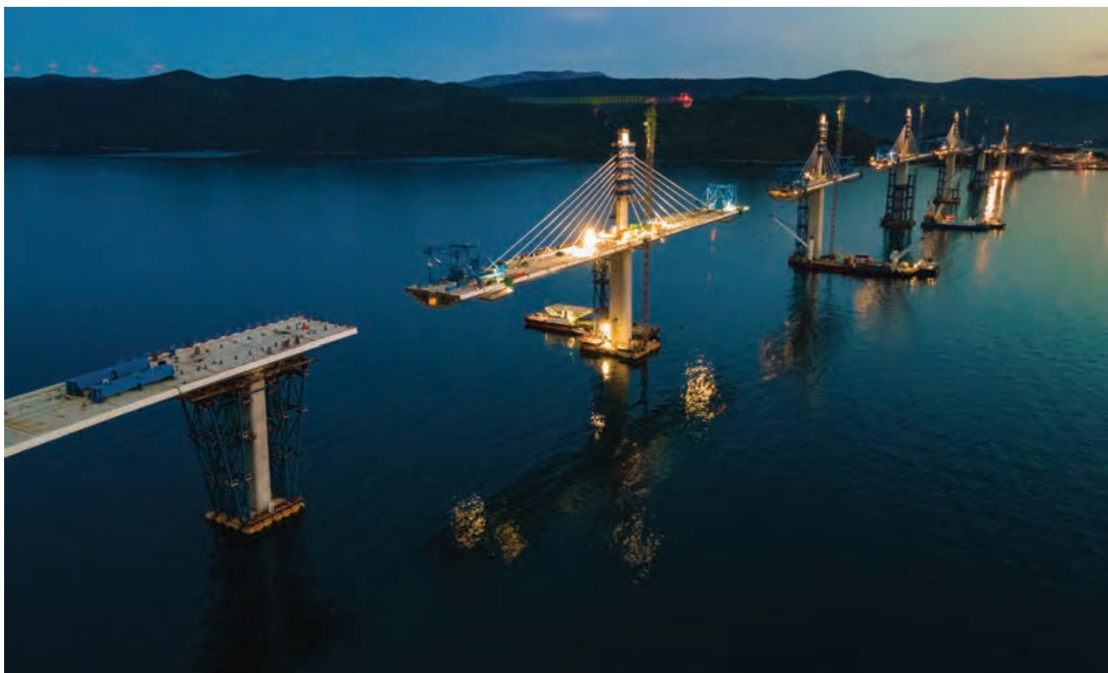
Pelješki most u Kanalu Malog Stona, konzolna gradnja montažom čeličnih odsječaka uz pridržanje kosim zategama, svibanj 2021.
