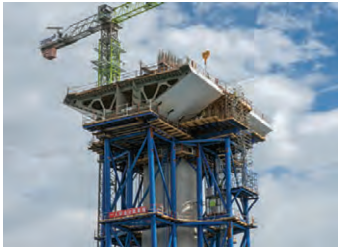
Prvi čelični elementi na skeli uz pilon S5 – lipanj 2020.
