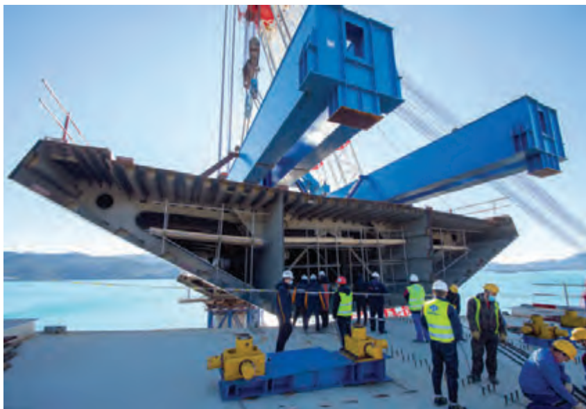
Spuštanje segmenta čelične grede na mjesto ugradnje u dijelu sklopa koji nije ovješeno, goleme grede iznad nosača mosta služe privremenom pridržanju konstrukcije koja teži oko 800 tona tijekom zavarivanja.
