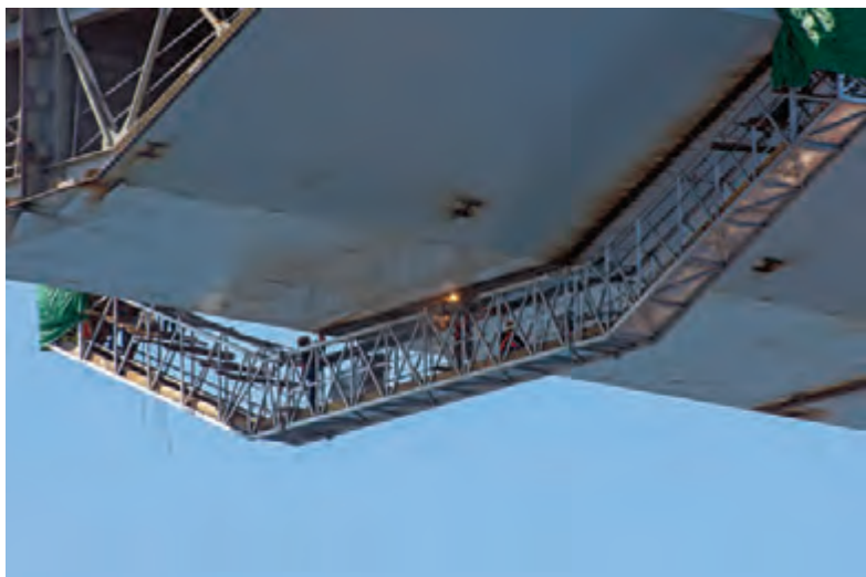
Zavarivanje obodnog spoja segmenata mosta odozdo.
