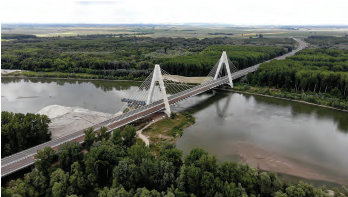
Most Drava na autocesti A5, Svilaj – Osijek – Beli Manastir, sadrži spregnuti sklop dug 420 m, širok 30 m u kojeg je ugrađeno 5.000 tona čelika
