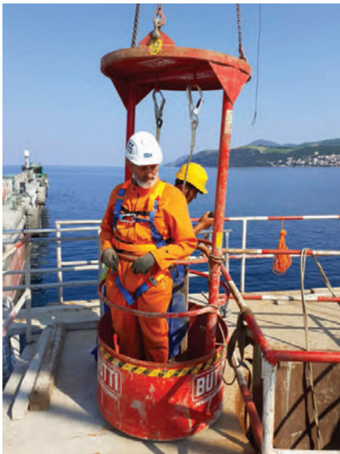
Košara za pregled unutrašnjosti pilota spušta se dizalicom u očišćeni dio cijevi, do dna prostora koji će biti ispunjen armiranim betonom. U košari je nadzorni inženjer s kineskim operaterom.
