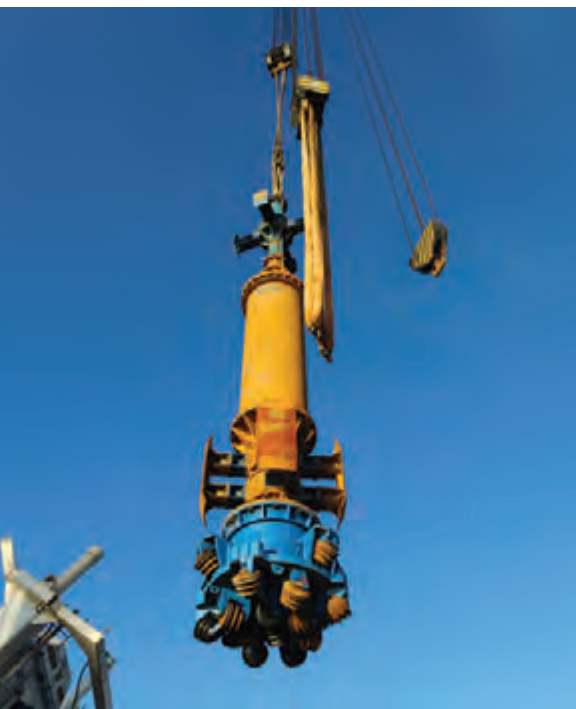
Bušača glava za RCD bušenje materijala koji je ostao u cijevi pilota nakon zabijanja.
