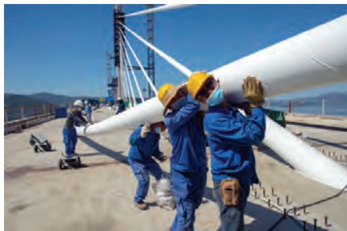
Postavljanje zaštitne cijevi kose zatega, vidljiva su zavojska ispuščenja koja služe sprječavanju oscilacija u posebnim okolnostima
