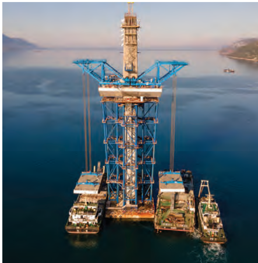
Podizanje prvih odsječaka, duljine 12 metara, koji će biti pridržani zategama, pomoću derrick dizalica na baznim elementima pilona S7 u prosincu 2020., vidljivi su krajnji dijelovi čeličnih sedala koje će prihvaćati zatege.
