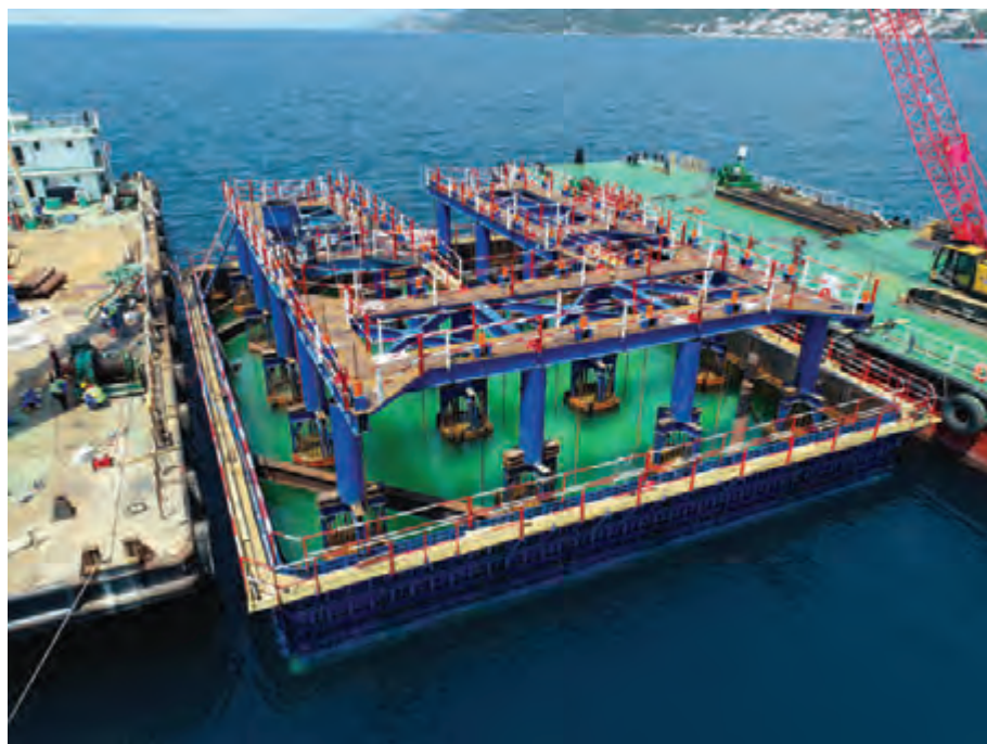
Oplata buduće naglavne ploče stupa spuštena na zadanu kotu. Prije ispumpavanja mora iz sanduka potrebno je zabrtviti otvore uokolo vrhova pilota (ožujak 2020.)
