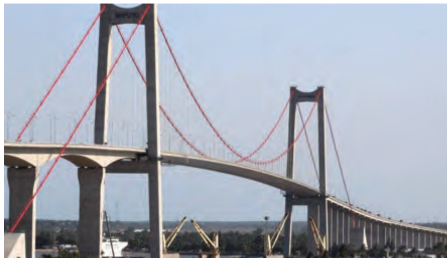
Most Maputo – Katembe u Mozambiku, izvoditelj CRBC
