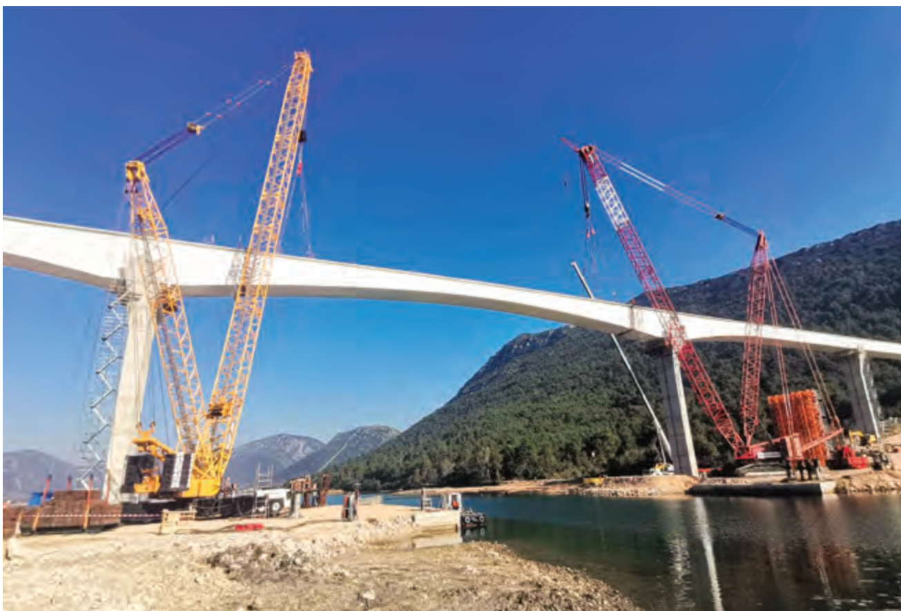
Gradilište mosta Ston, ožujak 2022.: podizanje središnjeg dijela konstrukcije nad zaljevom
