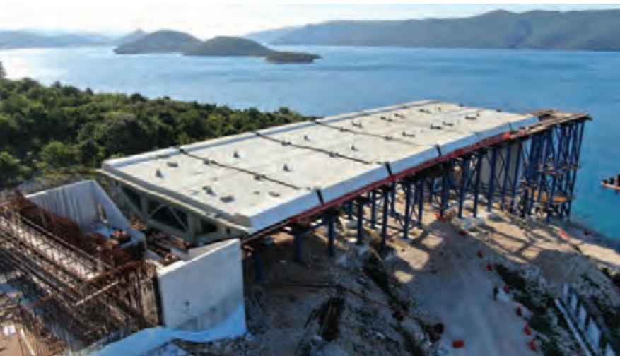
Prvi segmenti Pelješčkog mosta, na kopnenoj strani, postavljeni su u konačni položaj i pripremljeni za zavarivanje – svibanj 2020.
