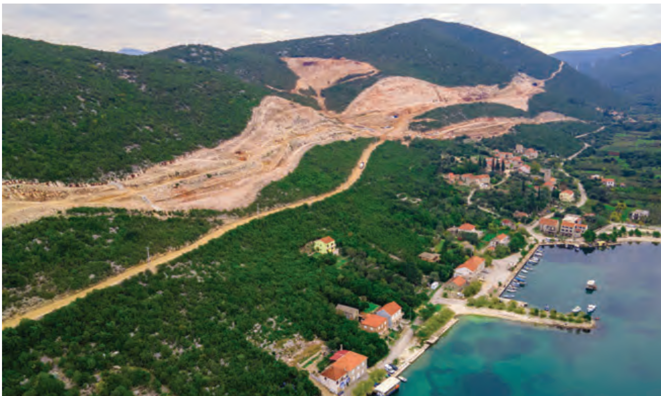
Gradilište čvorišta Brijesta iznad istoimenog naselja na Pelješcu, početkom 2022. godine.
