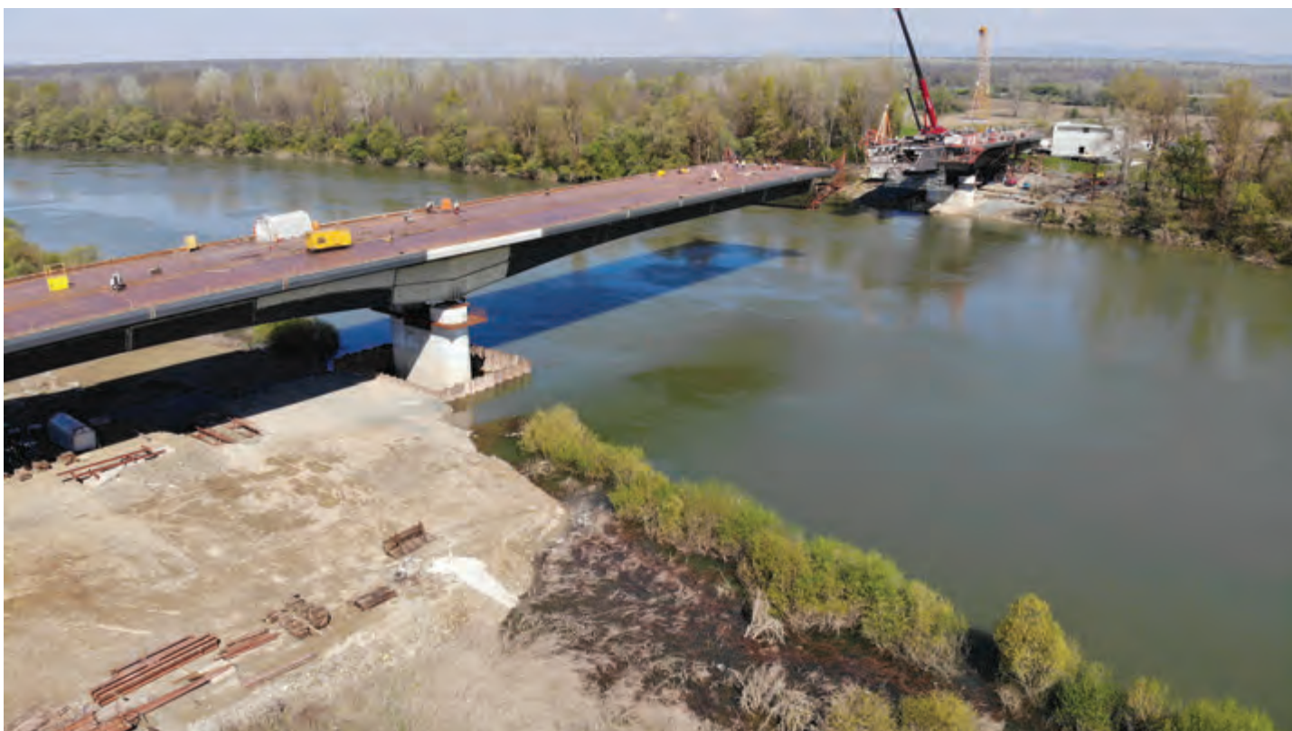
Most Sava kod Stare Gradiške, za brzu cestu, ima čelični sklop dug 462 m i širok 23 m u kojeg je ugrađeno 4.650 tona čelika
