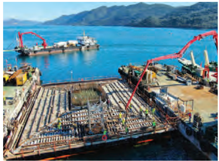
Betoniranje naglavnih ploča pilota u završnoj fazi. Naglavnice pilonskih stupova su vjerojatno najmasivniji betonski elementi ikada izvedeni u Hrvatskoj. U najveće naglavnice ugrađeno je po 3000 kubnih metara betona.
