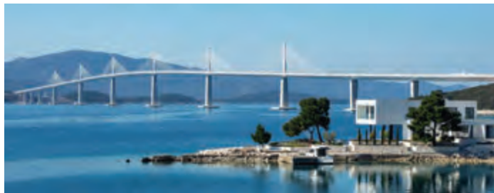
Čelična rasponska konstrukcija s tri komore i s ogradom za zaštitu od vjetra.
