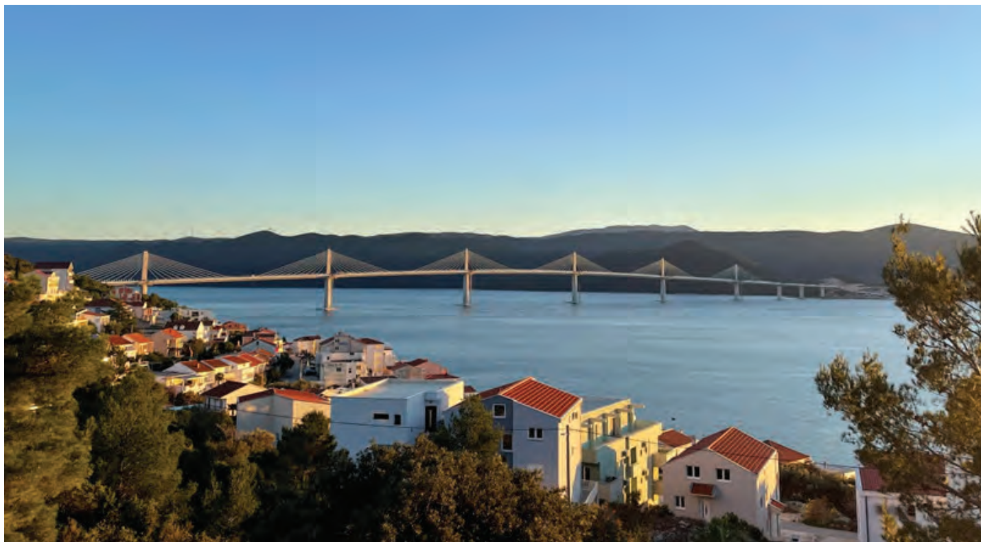
Pogled na Pelješki most s kopnene strane
