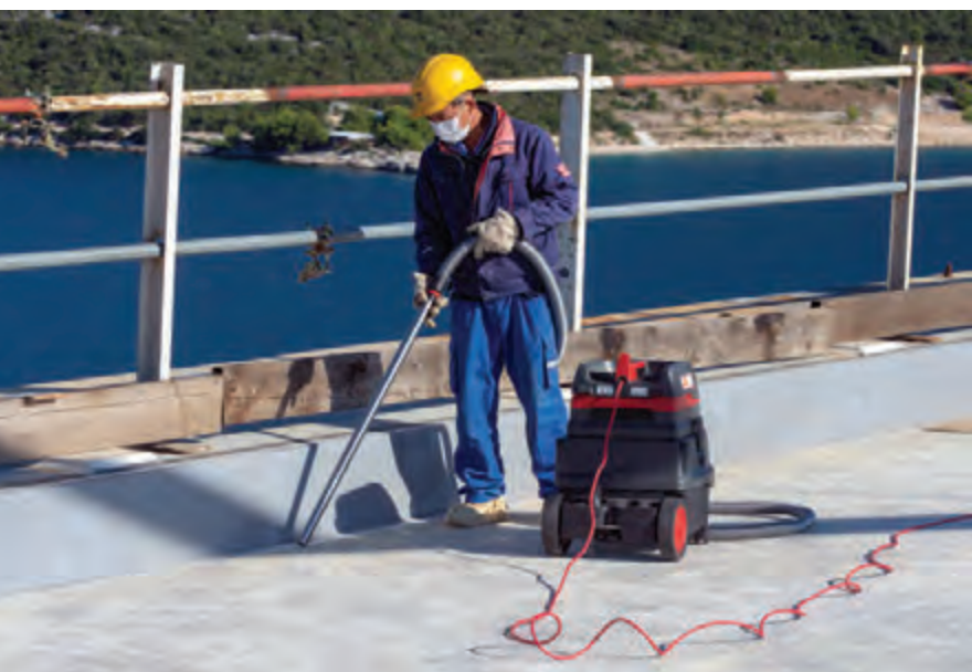
Čišćenje kolničke plohe prije polaganja sloja hidroizolacije.
