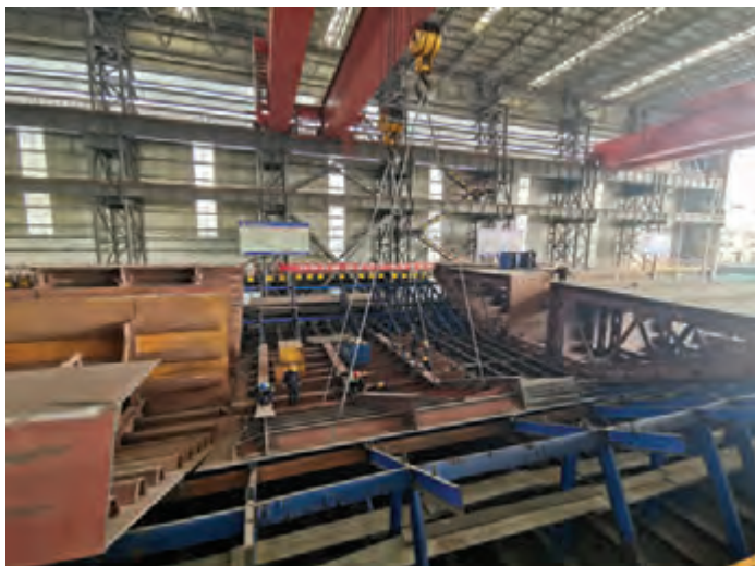
Izrada čeličnih elemenata Pelješkog mosta u tvornici u Kini
