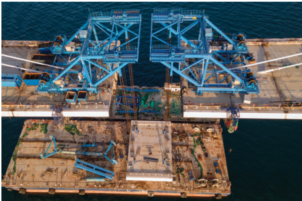
Podizanje upasnog segmenta između dviju konzola u srpnju 2021. Pri kraju konzole s lijeve strane vidljivi su tankovi s vodom koji se pune kako bi se konzole dovele u istu razinu, odnosno da bi se element koji ih povezuje ispravno uklopio.
