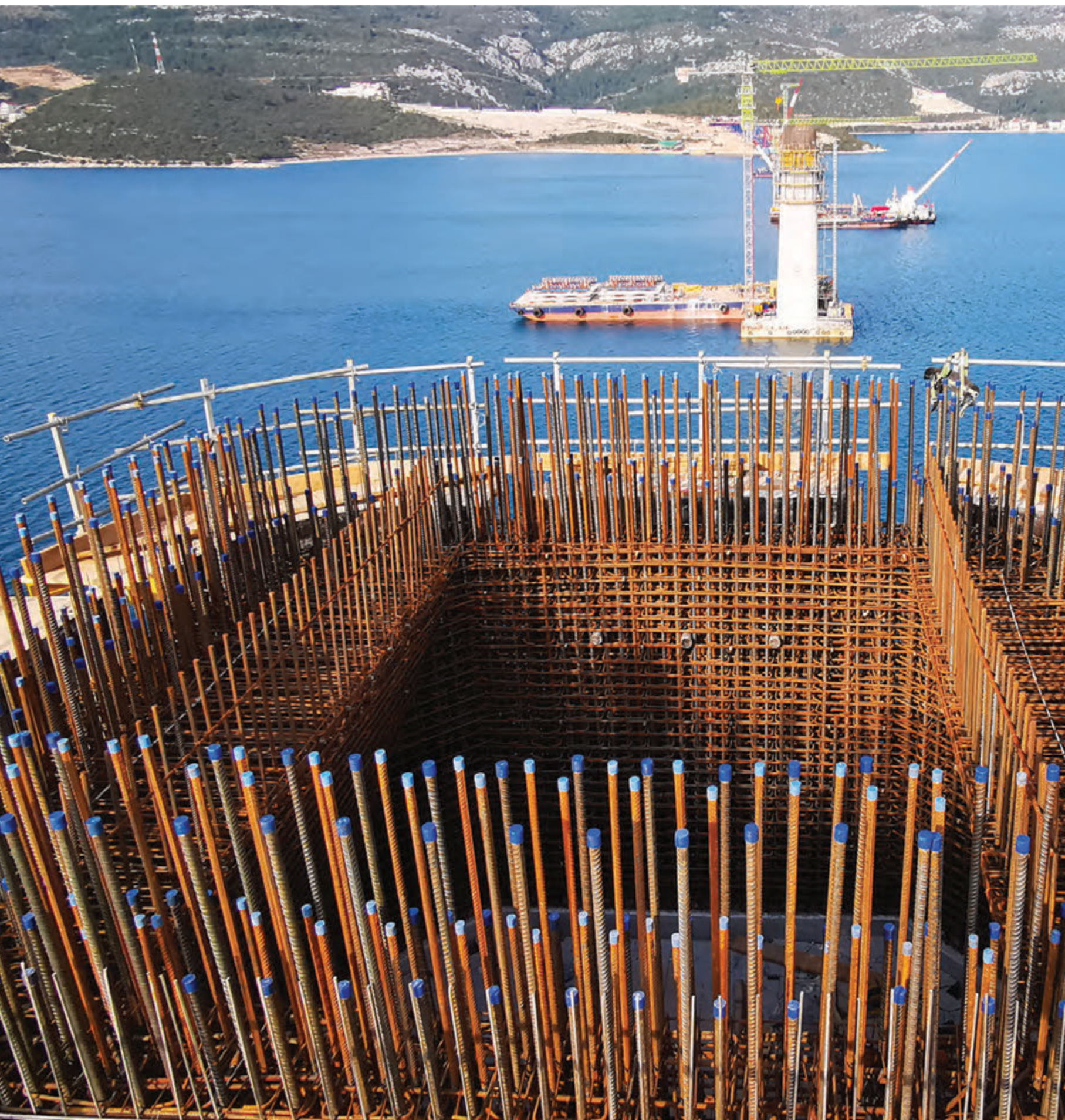
Armaturni koš na stupu prije betoniranja
