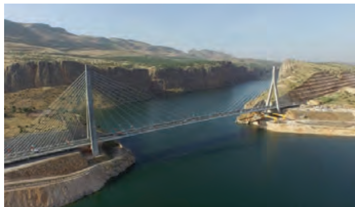
Most s kosim zategama Nissibi preko rijeke Eufrat u Turskoj s glavnim rasponom od 400 m – vijadukt Črni Kal i ovaj most uvrstili su Marjana Pipenbahera među vodeće projektante mostova u svijetu.
