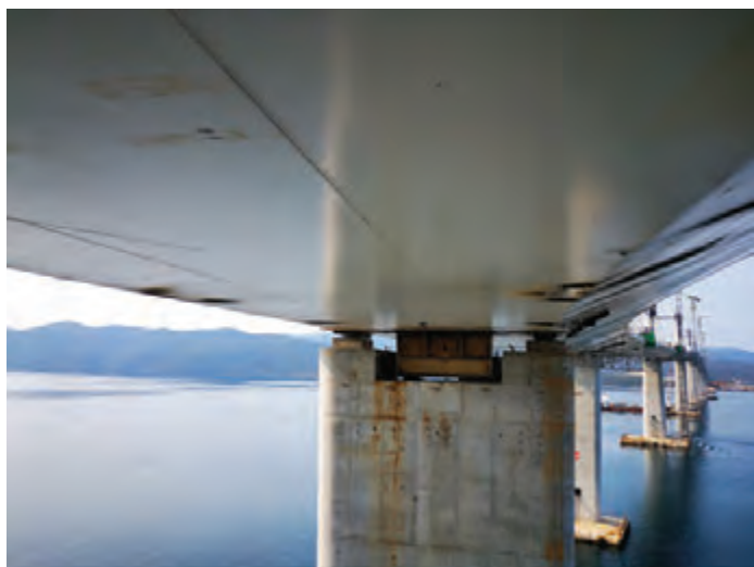
Ležajevi i vodilica na vrhu stupa S3 |
