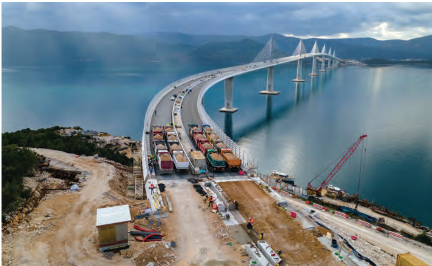
Probno opterećenje Pelješkog mosta izvršeno je pomoću dvadeset kamiona mase od po 40 tona
