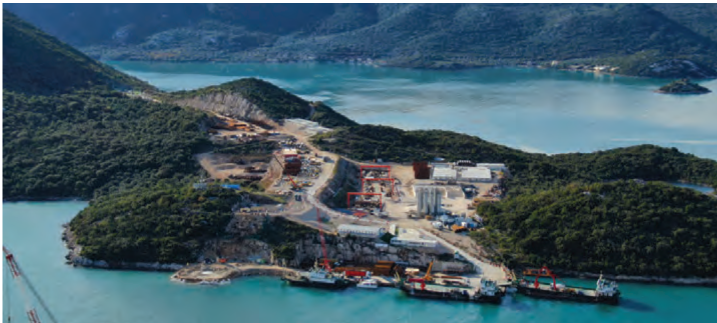
Gradilište s postrojenjima, radničkim naseljem i operativnom obalom kraj Brijeste na Pelješcu krajem 2019. godine.
