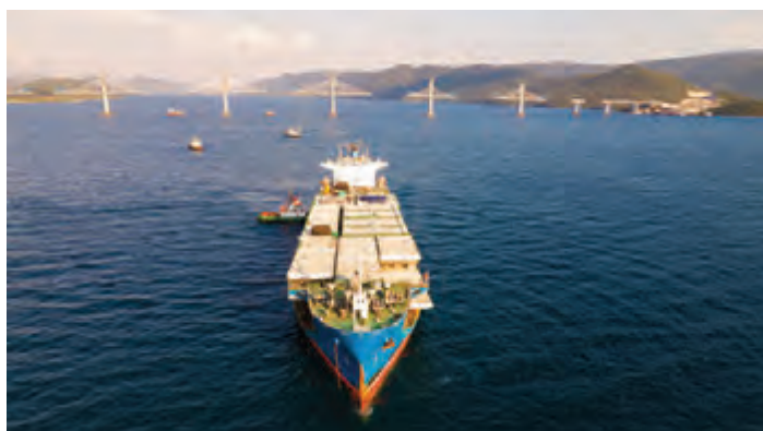
Spajanje prvog raspona nad morem, siječanj 2021. |
