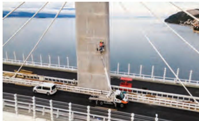
Postavljanje kamera za nadzor prometa na mostu |
