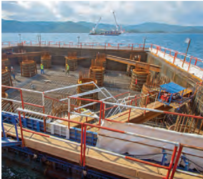
Unutrašnjost sanduka – oplave naglavne ploče tijekom armiranja
