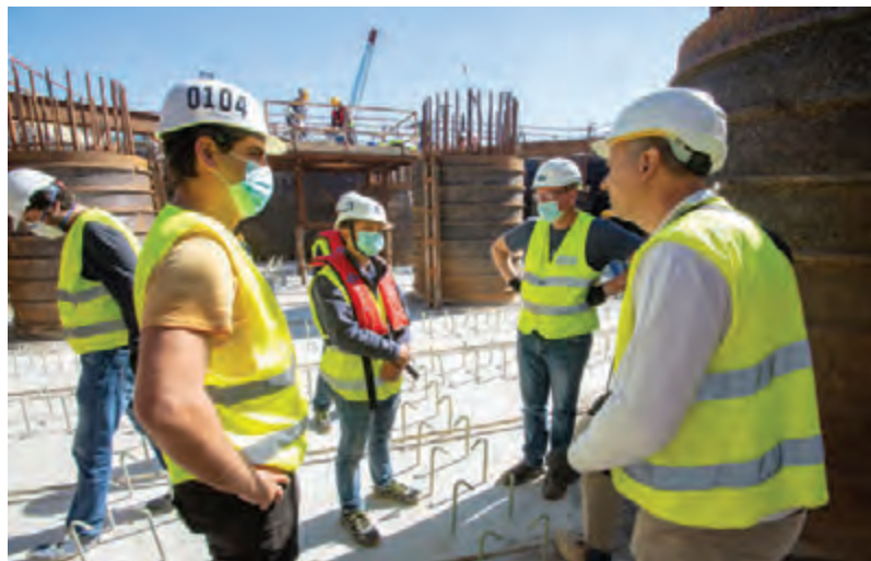
Nadzor je kontrolirao i odobravao sve radove - pred betoniranje dijela pilona (gore) i pred polaganje armature u oplatu naglavne grede..
