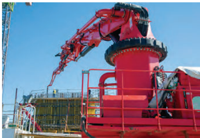
Pumpanje betona s trajekta u oplatu stupa.
