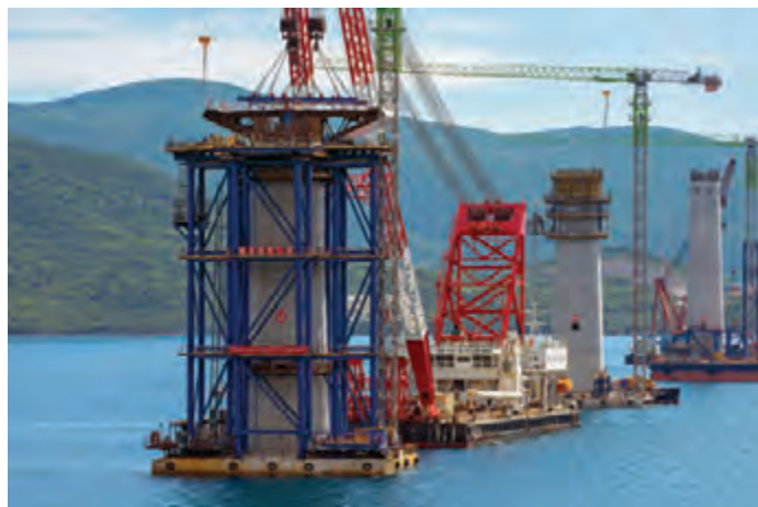
Pripremljen oplatni sanduk za prvu naglavnicu pilota, srpanj 2019. |
