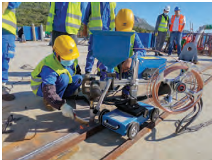
Uređajima za poluautomatsko zavarivanje izrađivani su spojevi na kolničkoj ploči i to djelomično, rađena je ispuna zavora, dok su većina zavora načinjena ručno.
