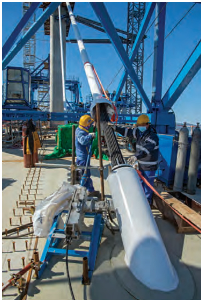
Uvlačenje užeta u zaštitnu cijev s kolnika – snop užadi od žica čini kosu zategu
