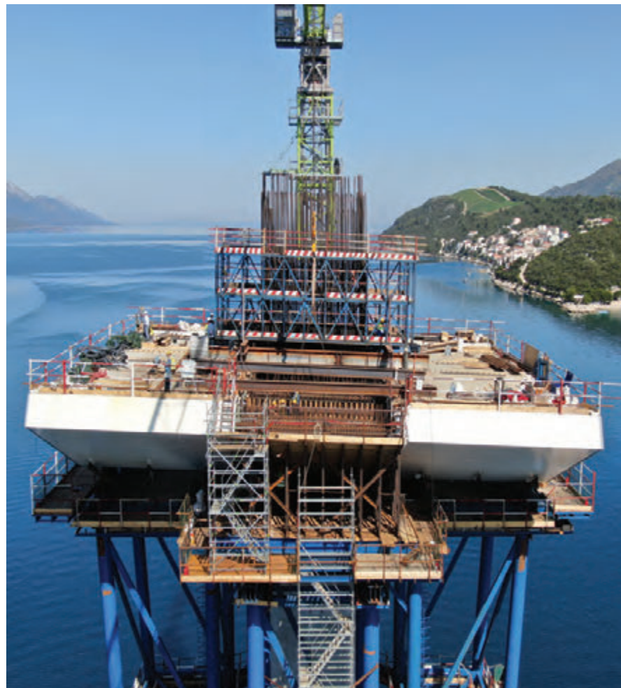
Povezivanje prvih odsječaka čeličnog sklopa mosta s konstrukcijom pilona – formiranje krute veze dodatno se ostvaruje povezivanjem prednapetim kabelima. Izgradnja pilona S5 u lipnju 2020.: prvi čelični odsječci uz stup postavljeni su na mjesto, na skeli, između njih, izravno nad stupom priprema se betoniranje.
