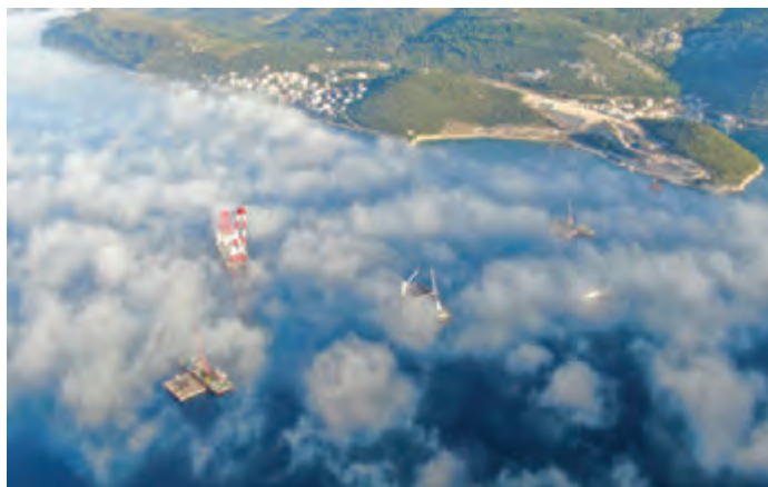
Gradilište u listopadu 2019.
