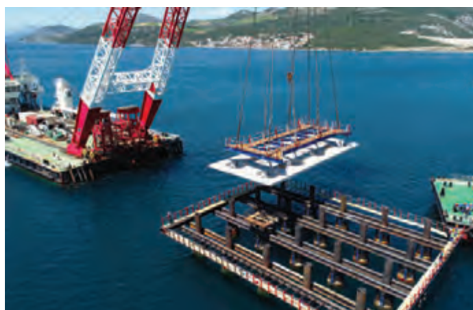
Prijevoz i postavljanje jednog elementa dna temeljne ploče (naglavnice) na privremene oslonce u produžetku pilota: u prvoj fazi oplata naglavnice formira se nad razinom mora. Pomoćna čelična konstrukcija kasnije se uklanja.
