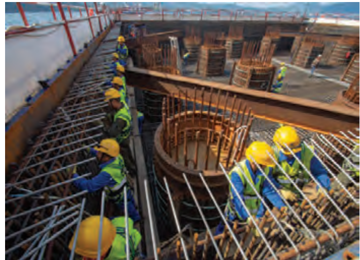
Kineski radnici su na gradilištu bili vrlo disciplinirani, na slici: armiranje naglavne ploče pilota.
