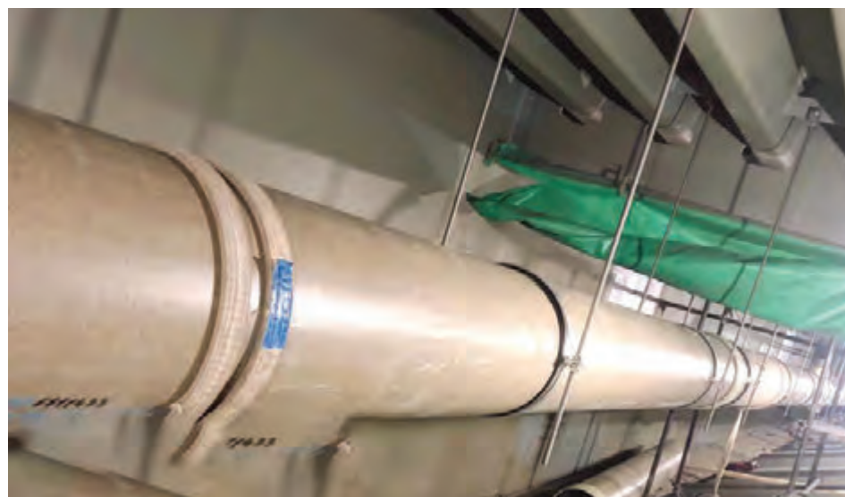
Cijevi sustava odvodnje s kolnika mosta u unutrašnjosti rasponskog sklopa.
