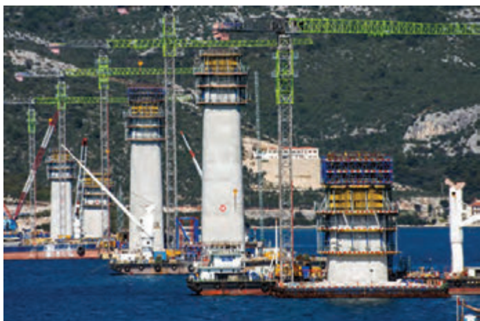
Izvedba donjih dijelova pilona 2020. godine: svaki stup u moru praktično je zasebno gradilište.
