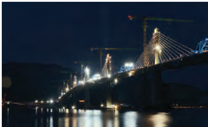
Podizanje posljednjeg segmenta čeličnog sklopa 28. srpnja 2021. |
