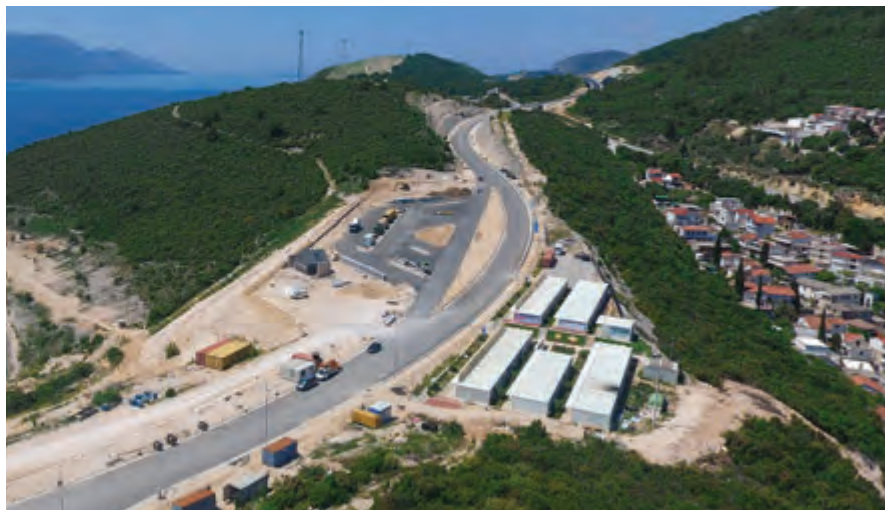
Pristup Mostu Pelješac s kopnene strane – odmorište Komarna u izgradnji.
