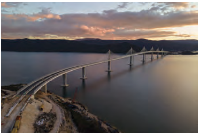
Završno otklanjanje nedostataka, radovi se privode kraju |
