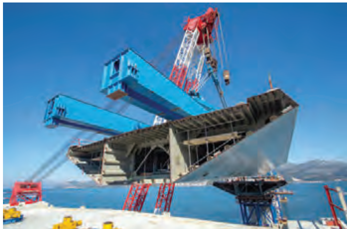
Spajanje prvog raspona nad morem, siječanj 2021. |
