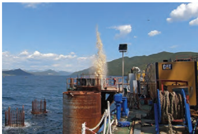
Pokušaj uklanjanja oštećenog dijela pilota temelja stupa S12 eksplozivom nije uspio.
