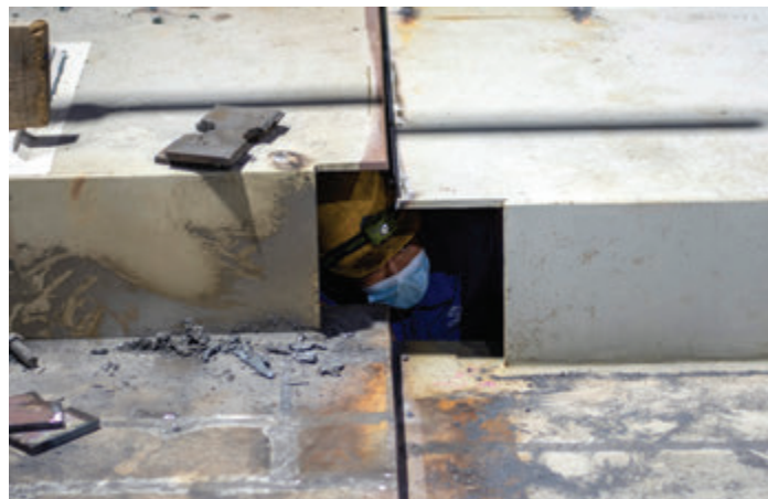
Fino podešavanje položaja segmenata mosta prije konačnog spajanja zavarivanjem.
