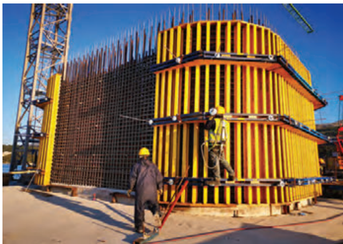
Oplata prve kampade (odsječka koji se betonira odjednom) pilona S5, prosinac 2019., gusto postavljena armatura indicirala je uporabu samozbijajućeg betona.
