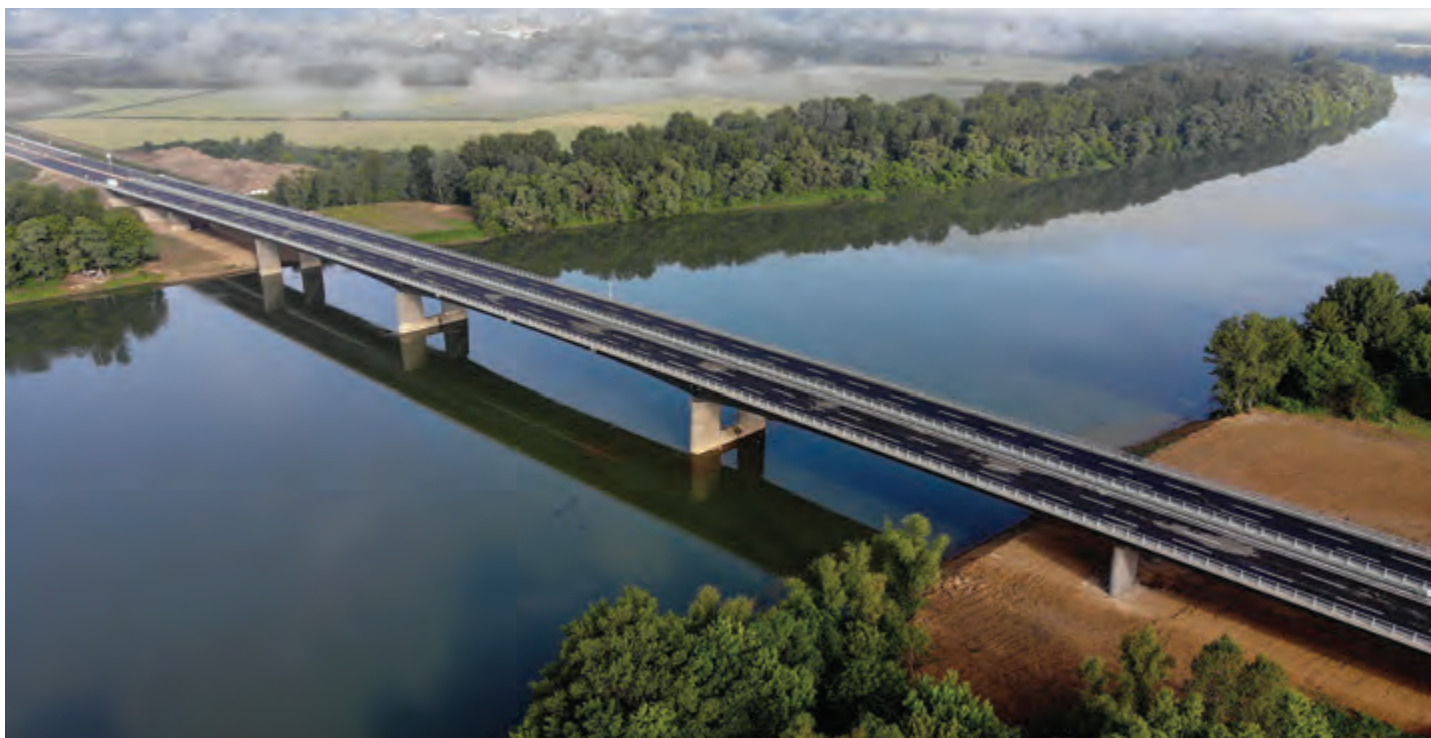
Most preko Save kod Svilaja, na autocesti A5, sadrži dva paralelna spregnuta sklopa duga po 660 m, široka po 13,5 m u koje je ukupno ugrađeno 5.300 tona čelika.
