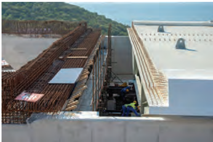
Završetak rasponskog sklopa na upornjaku prije ugradnje prijelazne naprave.
