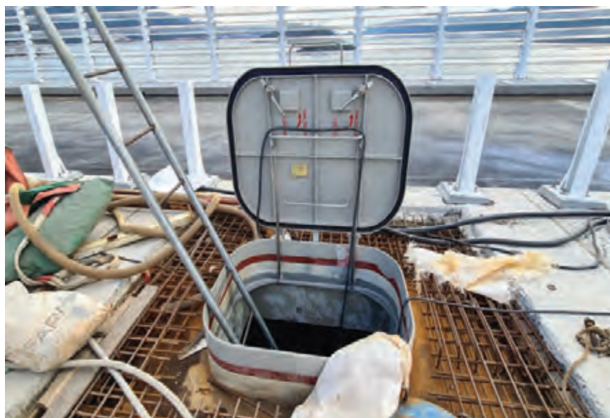
Ulaz u rasponski sklop mosta: vrata načinjena po uzoru na brodska u brodogradilištu Radež, na Korčuli.
