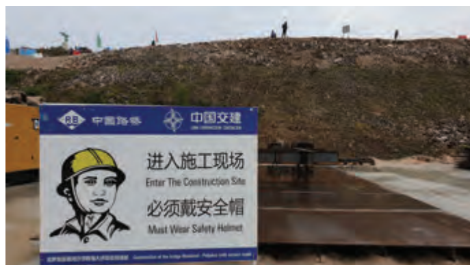
anel zaštite na radu i upozorenje vezano uz zaštitu okoliša, sa navedenom vrlo strogom kaznom – CRBC, gradilište Pelješkog mosta
