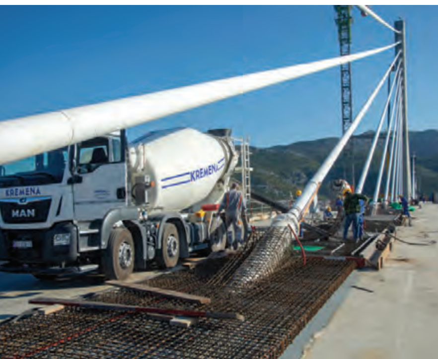
Betoniranje razdjelnog pojasa na rasponskoj konstrukciji mosta
