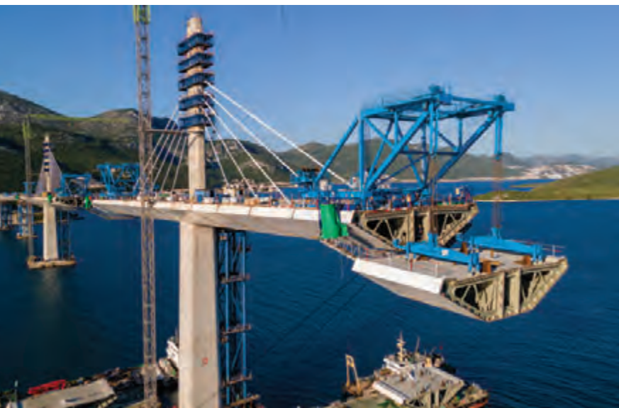
Pogled na pilon S6, slobodna konzolna gradnja, svibanj 2021.
