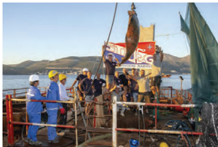
Vađenje deformiranog dijela cijevi pilota nakon podmorskog rezanja.
