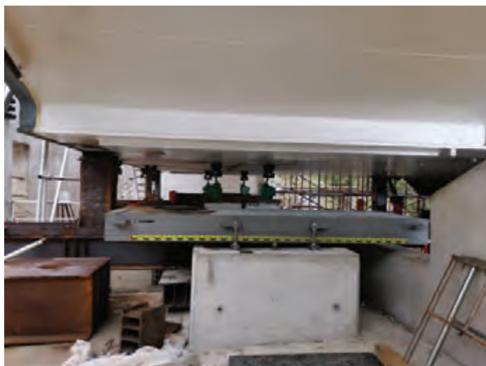
Sferni ležaj na upornjaku prije konačnog spuštanja konstrukcije na oslonac |
