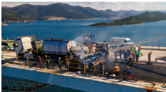
Ugradnja asfaltnog zastora na kolniku, listopad 2021. |
