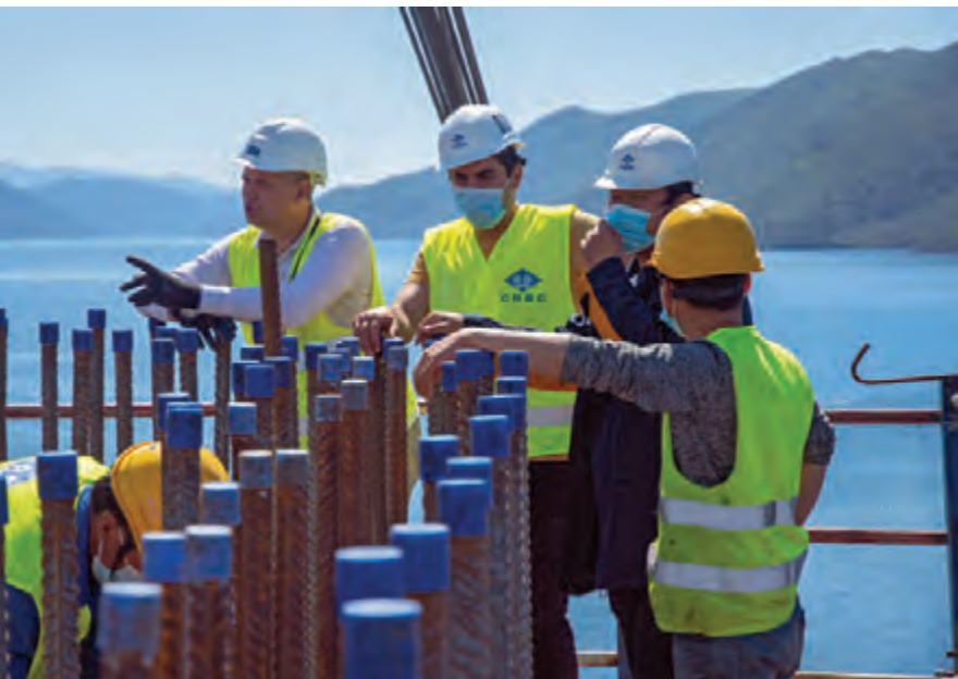
Nadzor je kontrolirao i odobravao sve radove - pred betoniranje dijela pilona (gore) i pred polaganje armature u oplatu naglavne grede..
