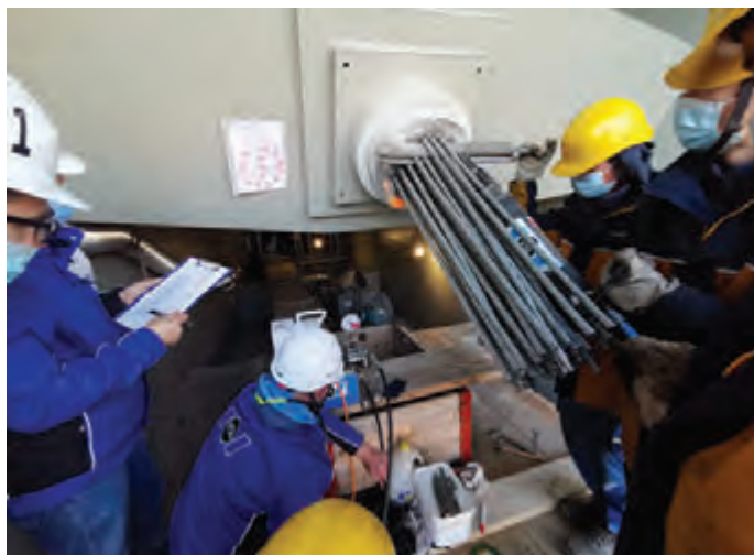
Napinjanje užadi kose zatege izvodi se pomoću kompaktne hidrauličke preše, po zadanom protokolu, do postizanja sile koja se mjeri na instrumentu u sredini kadra.
