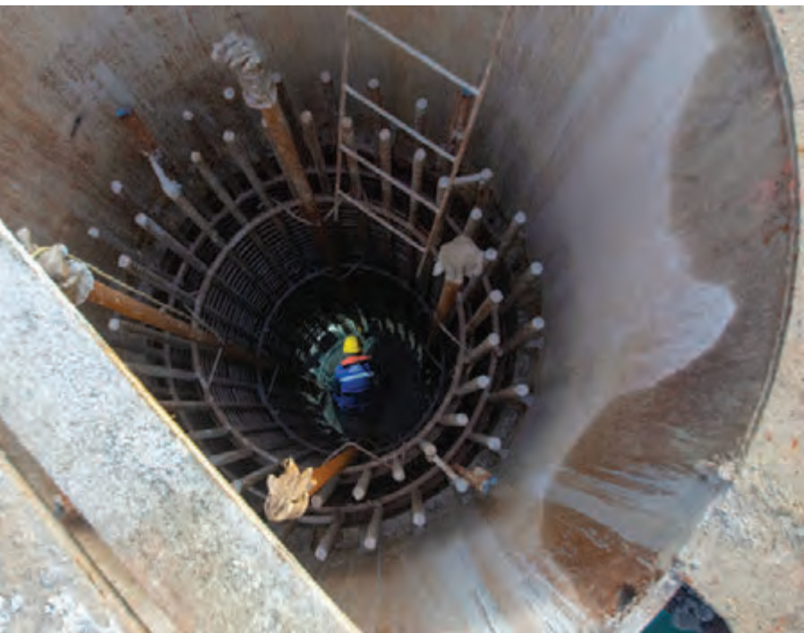
Pogled u unutrašnjost očišćenog pilota u koji je ubačena armatura. Stare rukavice štite vrh četiriju cijevi koje služe za ispitivanje integriteta pilota nakon betoniranja (Crosshole Sonic Logging).
