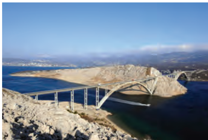
Krčki most, s armiranobetonskim lukom rekordanog raspona od 390 metara, dovršen je 1980. godine
