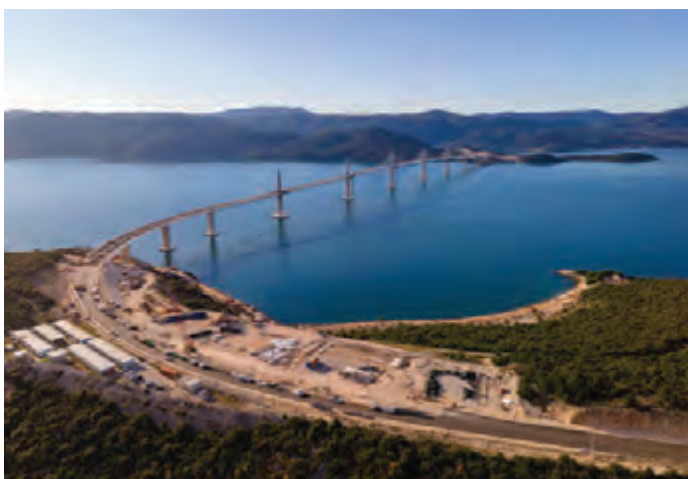
Završni radovi u prosincu 2021. |
