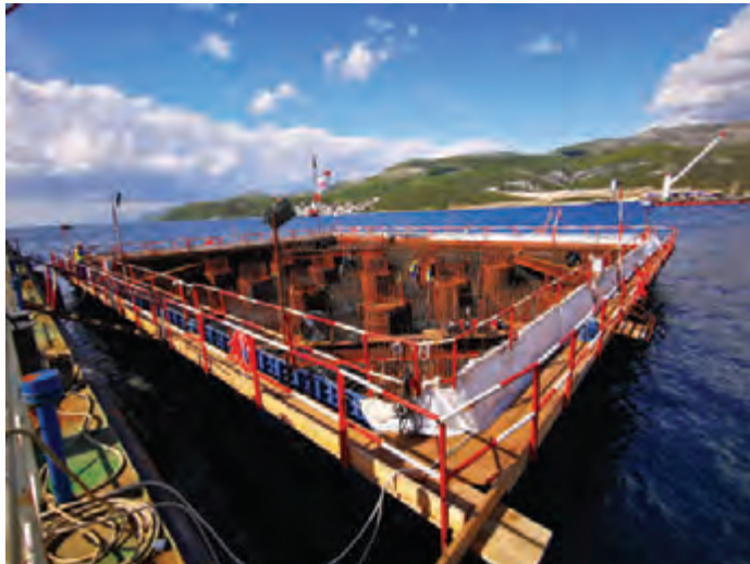
Nakon što je sanduk nad pilotima zabrtvljen, a more ispumpano iz njega, postavlja se armatura naglavne ploče
