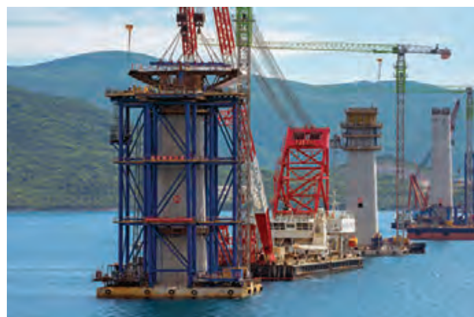
Postavljanje prvog baznog segmenta grede u svibnju 2020. |
