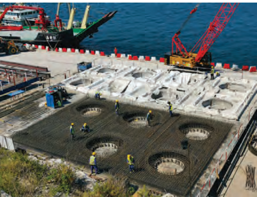
Betoniranje dijelova dna temeljne ploče (naglavnice) na operativnoj obali kraj Brijeste, na Pelješcu.
