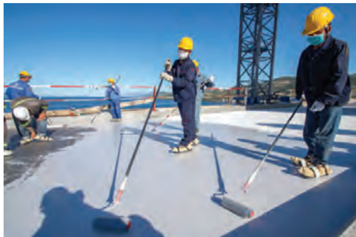
Polaganje hidroizolacije na kolničku plohu Pelješkog mosta, listopad 2021.
