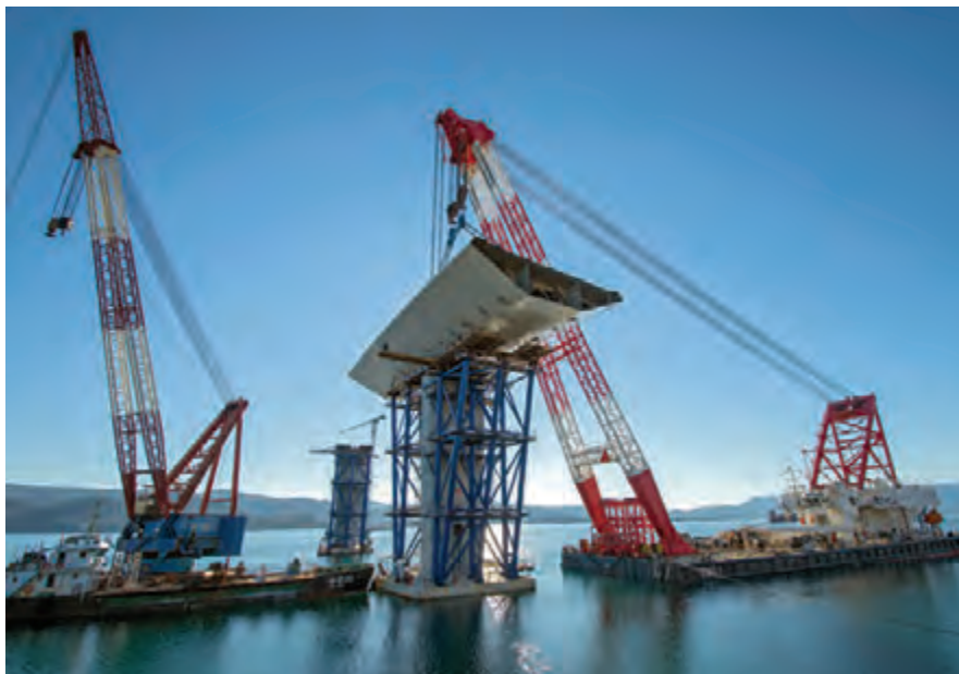
Postavljanje segmenta grede na stup S3, listopad 2020.
