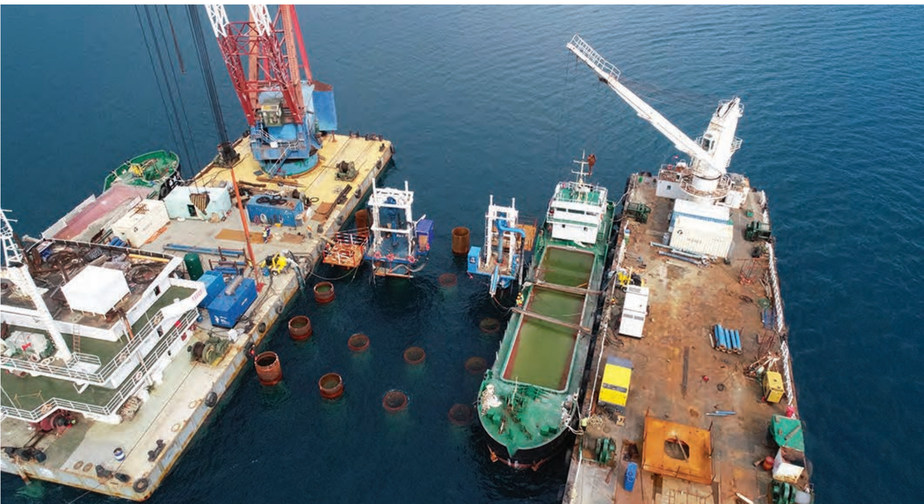
Uređaj za RCD bušenje tijekom pražnjenja gornjeg dijela jednog od pilota. Izbačeni materijal prikuplja se u brod s otklopnim dnom koji će ga odvesti
