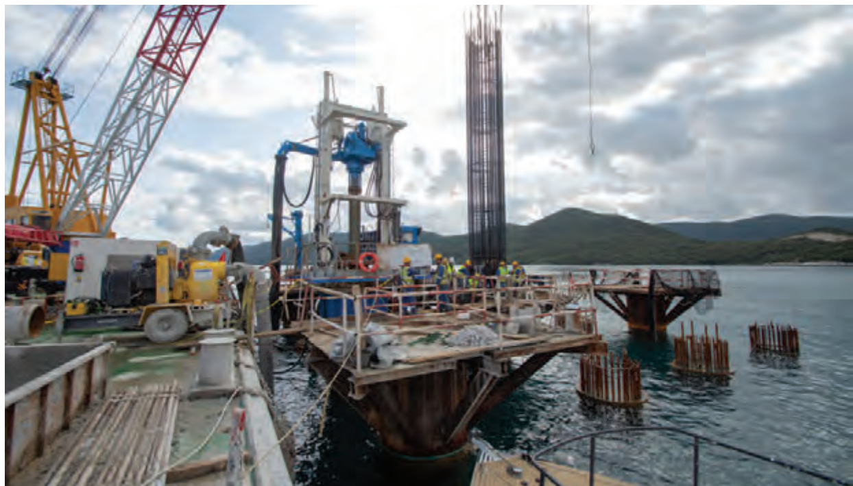
Piloti jednog stupnog mjesta u različitim fazama izrade betonske ispune: na jednom pilotu radi uređaj za bušenje, u susjedni pilot spušta se armaturni koš, a nekoliko ih je već pripremljeno i izbetonirano do vrha, na pilotima u radu su privremene konstrukcije koje formiraju radnu platformu.
