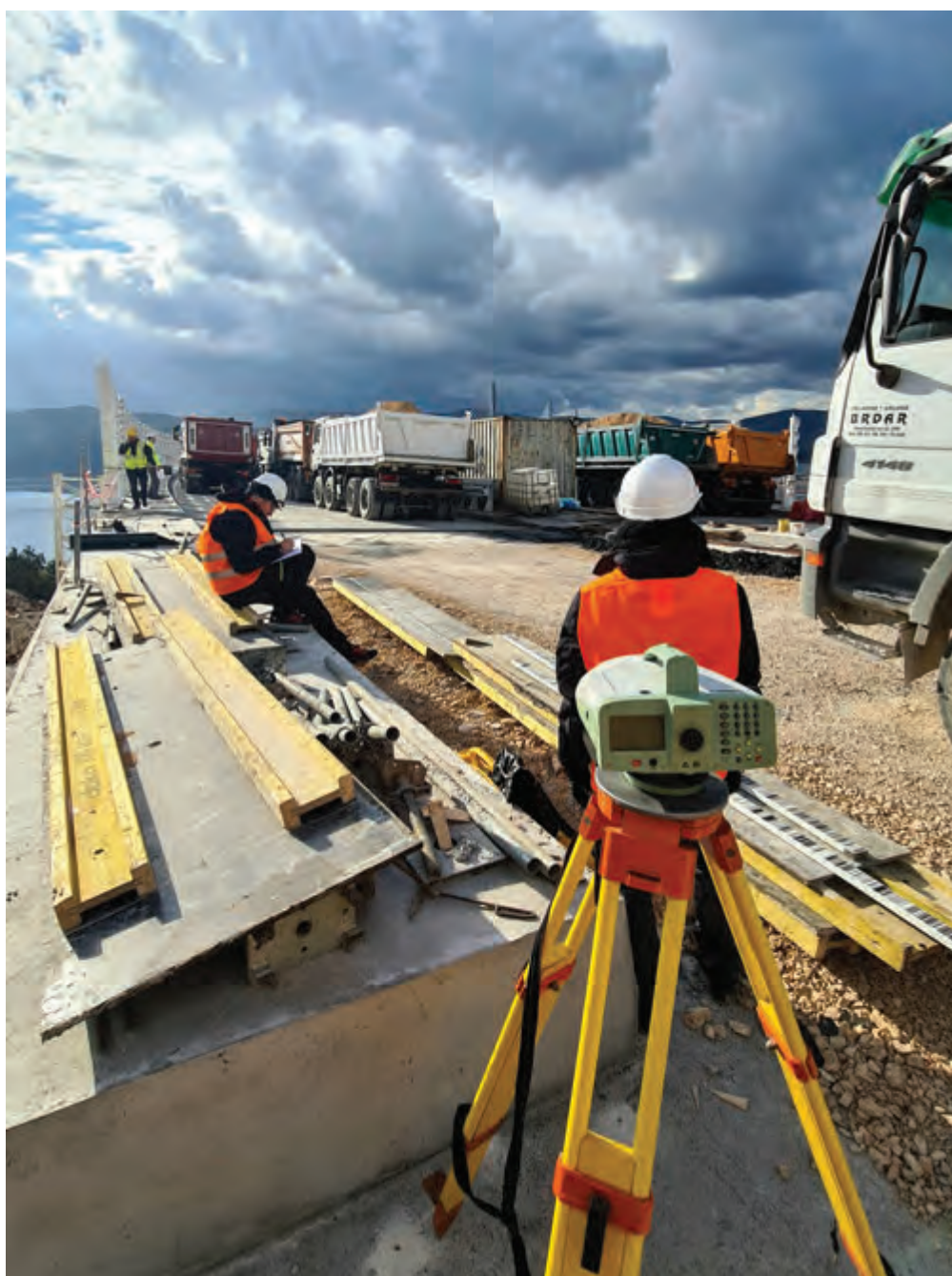
Geodetska oprema za praćenje pomaka pri probnom opterećenju
