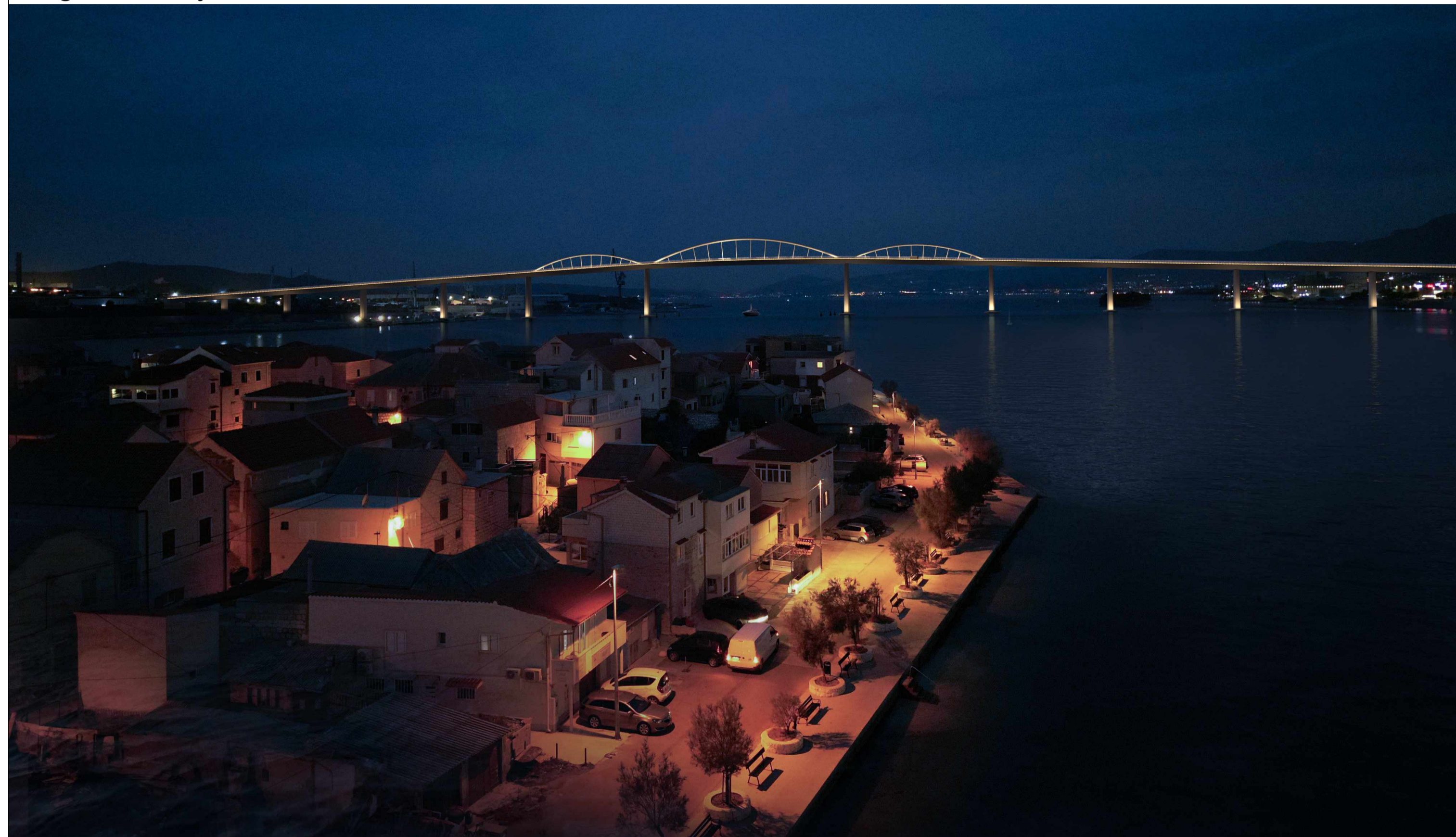
Pogled sa rasvjetom
