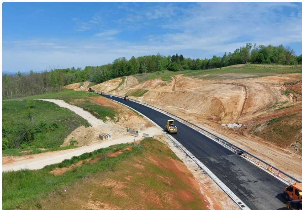
Obilaznica Turnja, odnosno ceste Mostanje – Vukmanički Cerovac kraj Karlovca
