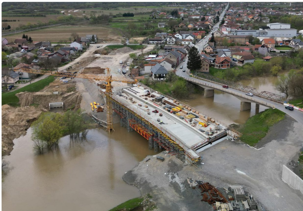
Izgradnja mosta preko Odra na spojnoj cesti između grada Siska i autoceste Zagreb – Sisak
