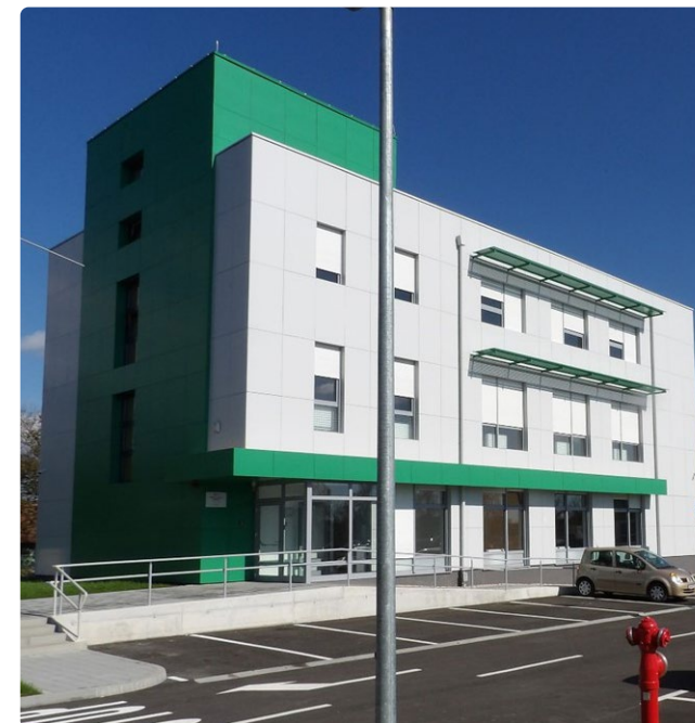
Nacionalna pristupna točka i Središnji centar za nadzor i upravljanje prometom na državnim cestama u Karlovcu
