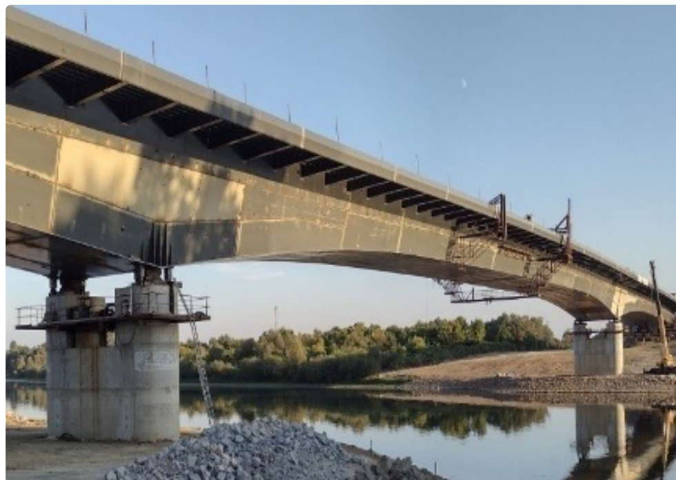
Granični most preko Save kod Stare Gradiške, između Hrvatske i Bosne i Hercegovine
